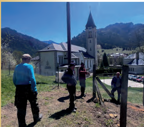
Oprava oplotenia vo farskej záhrade
